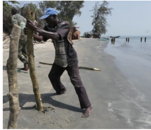
Figure 5 : Technique pour enfoncer les piquets
